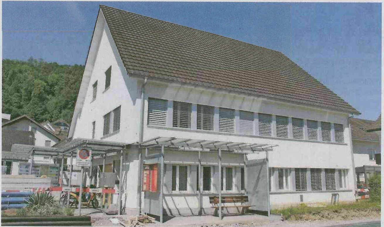
Erdgeschoss steht leer: Die frühere Gemeindekanzlei wird zum «Musighuus Schofise».
